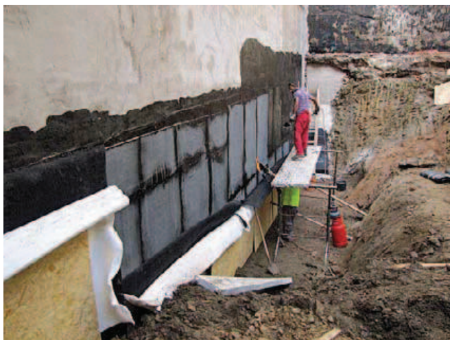
12| Natavování asfaltových pásů po záběrech na omítnutý a penetrovaný podklad, vespod již ochrana OSB deskou a hutněný zásyp. Ve hloubkách pod 4m je nutné svislou drenážní vrstvu provést z prostorové smyčkové ohože ve 2 vrstvách, nopolová fólie by se tlakem zborčila, případně by poškodila asfaltové pásy
