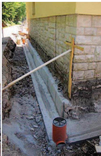
07| Úprava obnažené stěny základu přibetonováním, betonáž podkladního lože drenážního pera v definovaném spádu, na který se provádí drenážní pero z flexibilního drenážního potrubí a šterkového obsypu. V popředí kontrolní a čistící šachtice drenážního pera (osazuje se v místě každé změny směru nebo výškové úrovně)
