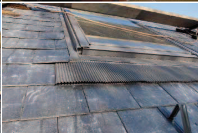
11| Detail napojení střešního okna
