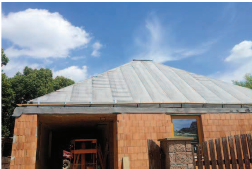
01 | Položení parozábrany TOPDEK AL BARRIER na záklop z dřevoštěpkových desek
