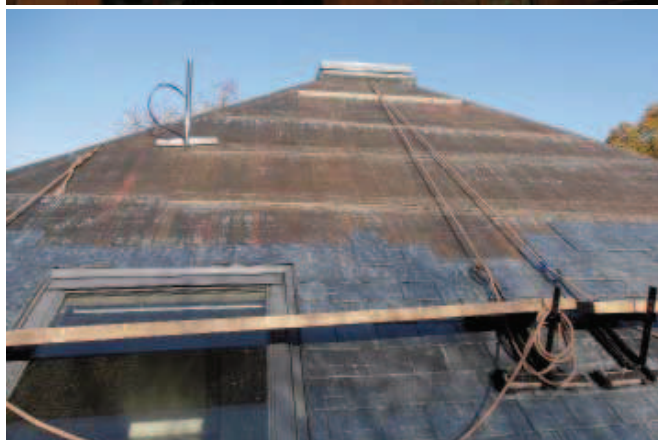
10| Pokládka kamenů z přírodní břidlice ve vodorovných řadách na dvojité krytí
