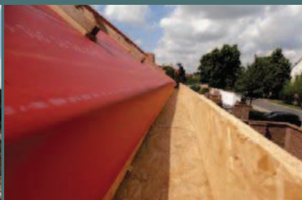
06 | Konstrukce žlabu z dřevoštěpkových desek
