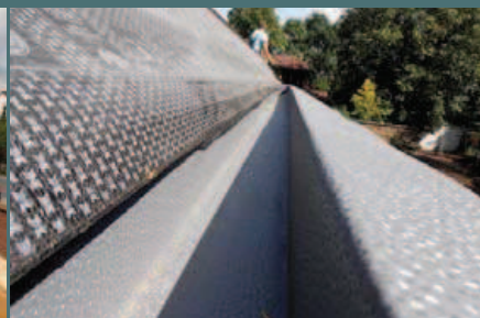
07 | Vyroření žlabu fólií z měkkého PVC
