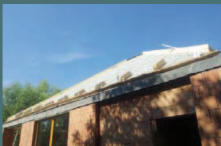
05 | Doplnění detailu pod žlabem tepelnou izolací
