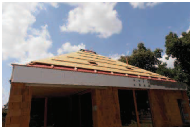
08| Plinoplošné bednění dřevoštěpkovou deskou jako podklad pro skládanou krytinu
