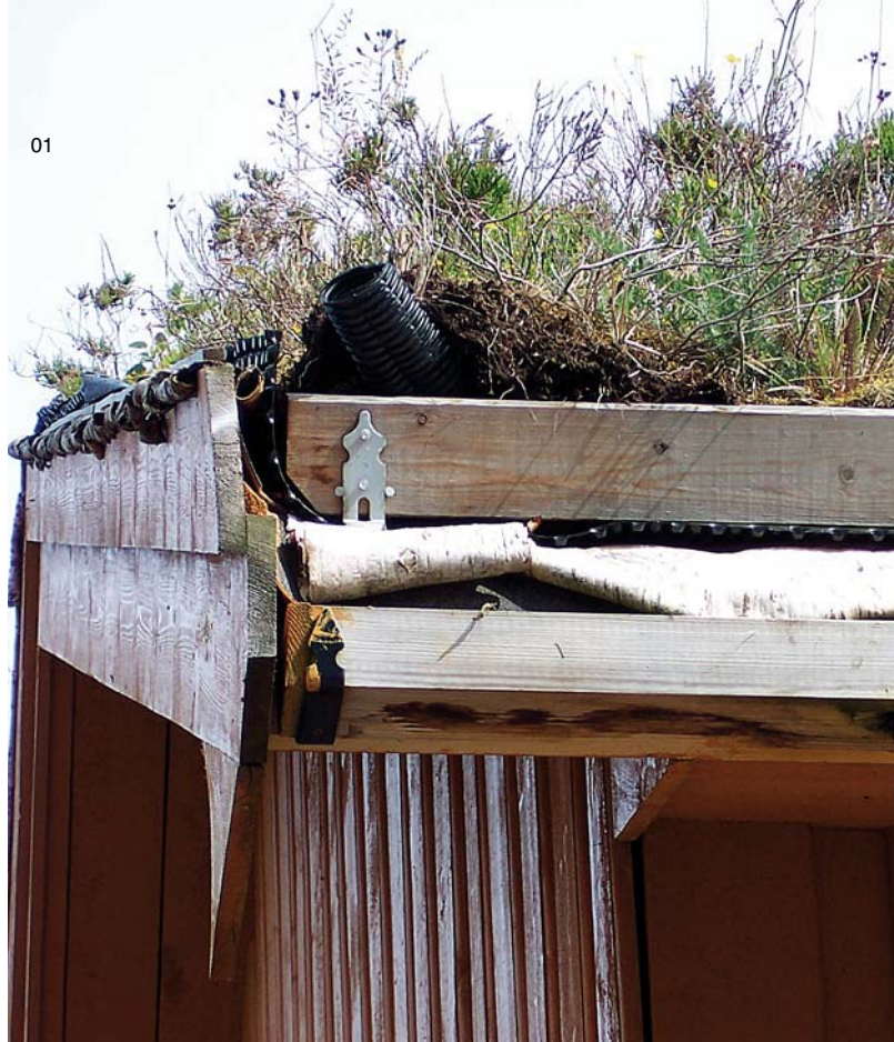
01 | Šikmá střecha s vegetační skladbou ve Skandinávii (jako ochranná vrstva hydroizolace je použita březová kůra)
