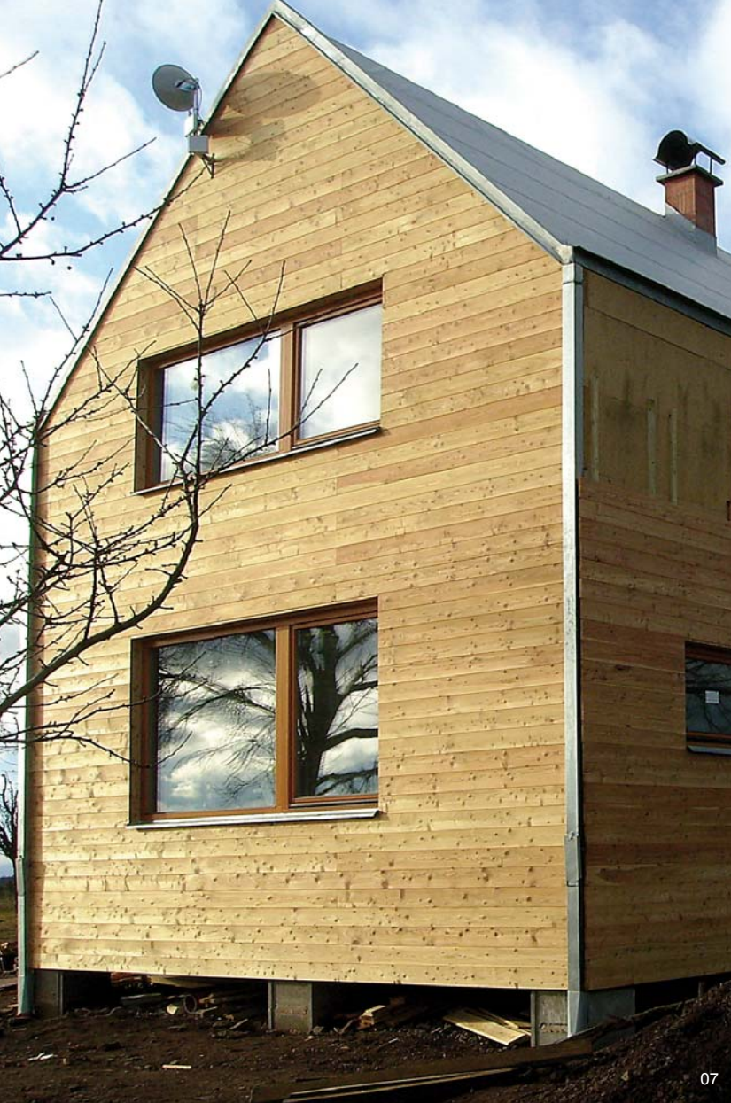
07 | Pohled na RD založený na betonových pilířcích
