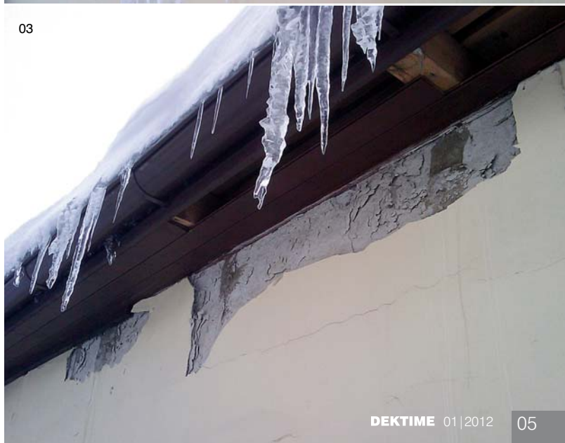
02, 03 | Degradace styku fasády a římsy
