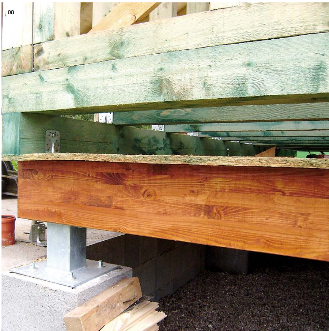
08 | Detail podlahy založené na betonových pilířcích
