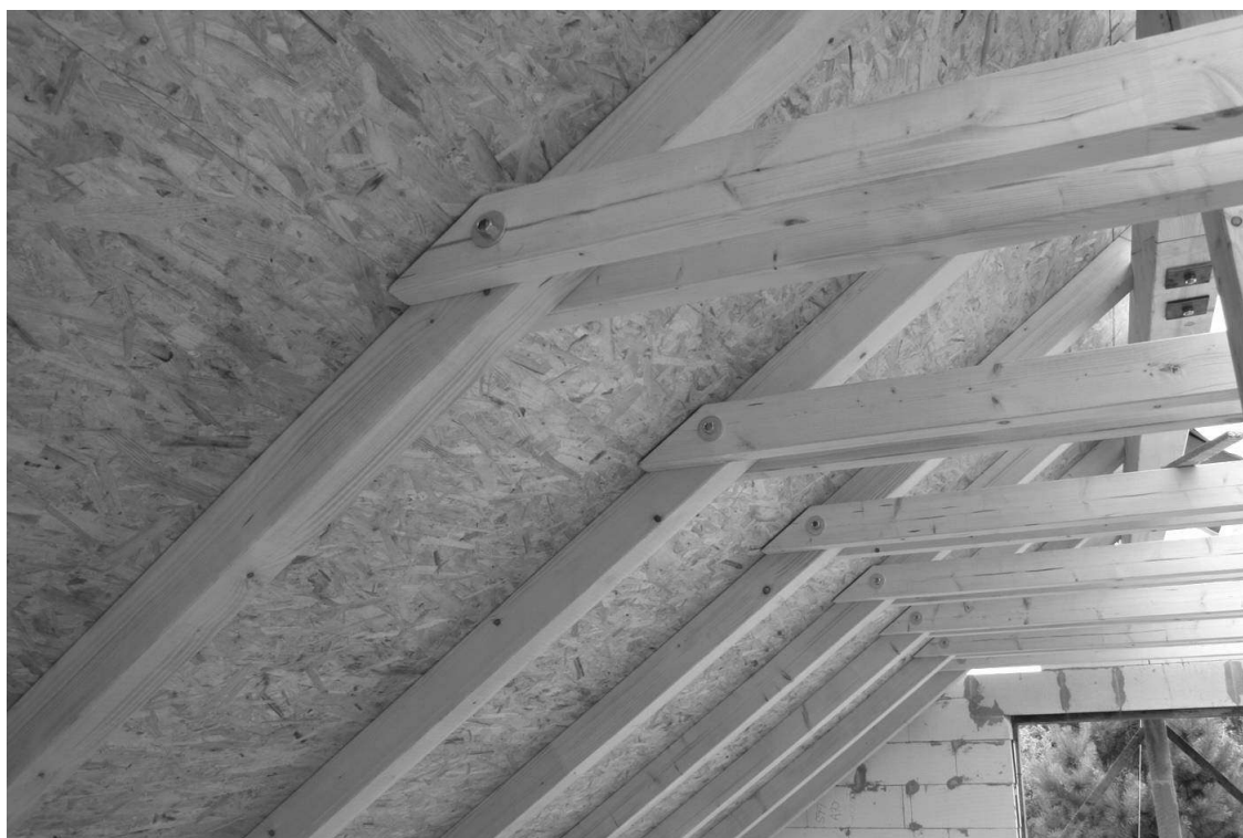
Obr 3. - Montáž bednění z desek OSB
