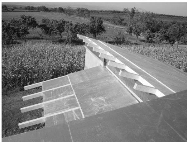
Obr 10. - Pokládka tepelněizolačních desek TOPDEK 022 PIR
