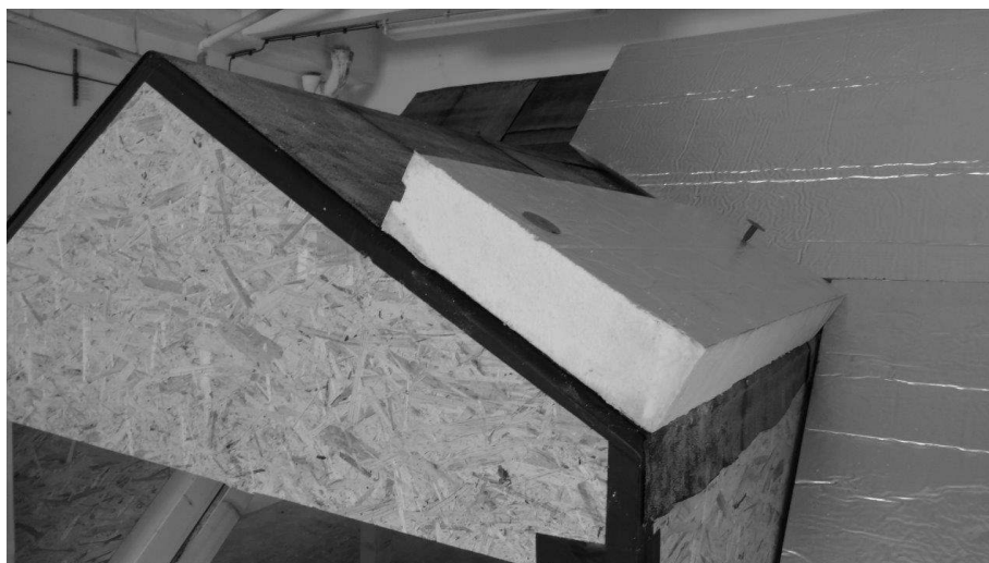
Obr. 31. Pracovní upevnění tepelněizolační vrstvy u okapní hrany
