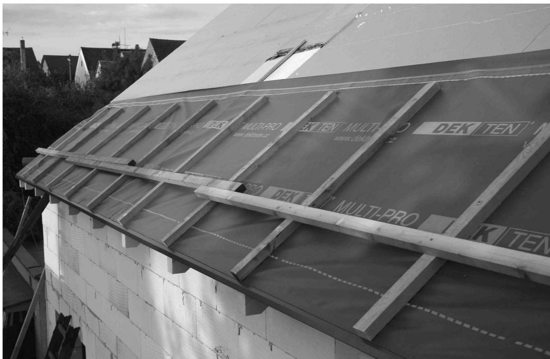
Obr 12. - Pokládka doplňkové hydroizolační vrstvy
