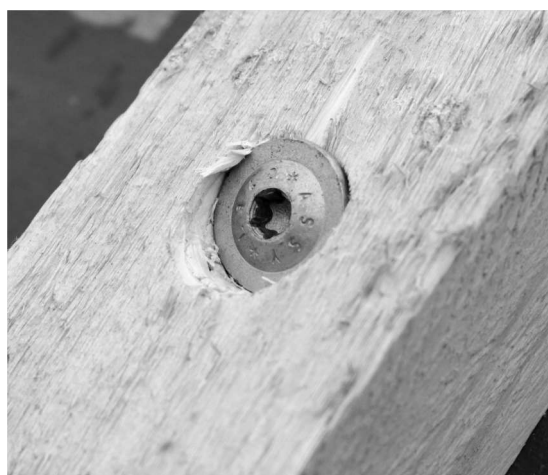
Obr 18. - Osazení vrtu B
