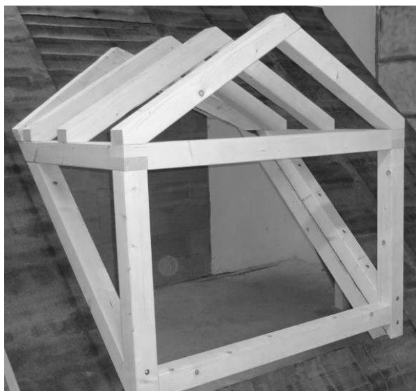
Obr. 27. Sestavená konstrukce vikýře
