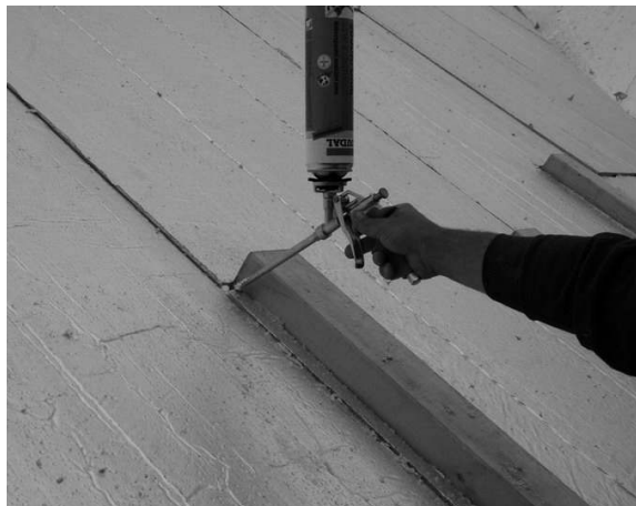
Obr 11. - Vypěnění spáry mezi tepelnou izolací a podporou montážní pěnou
