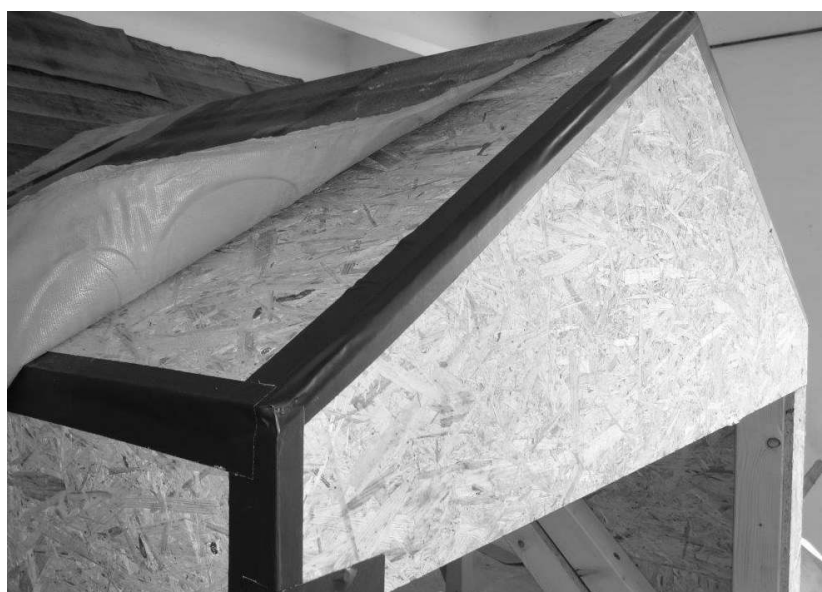
Obr. 30. Přelepení spár opláštění konstrukce vikýře
