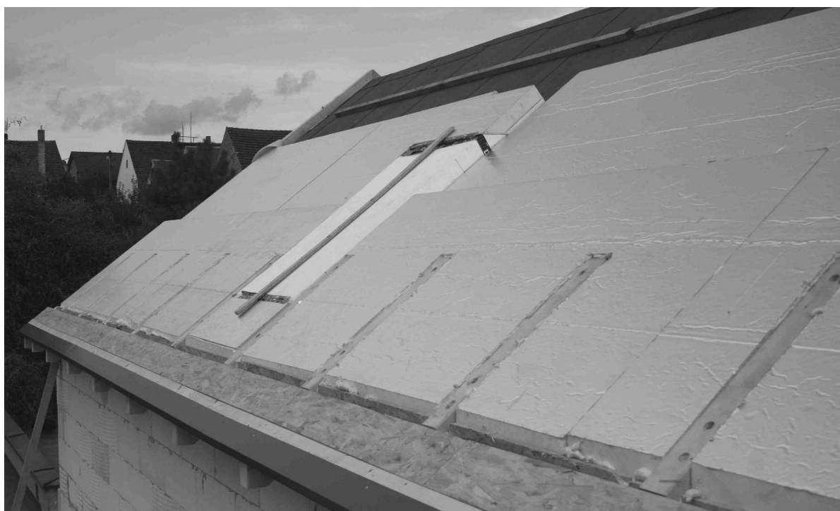
Obr 9. - Ukončení tepelněizolační vrstvy u okapu
