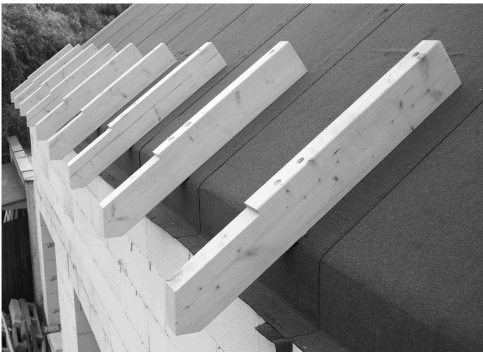
Obr 7. - Upevnění podpor přesahu střechy u okapu
