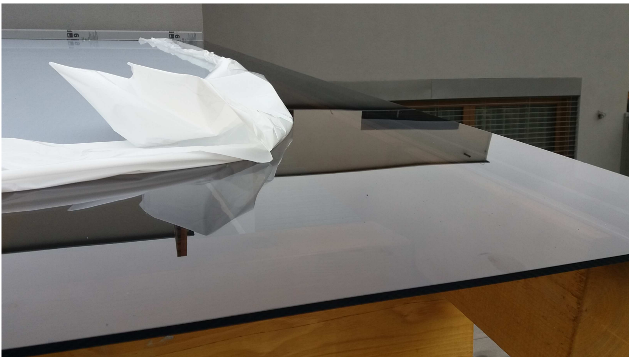
Foto 5. Před připevněním desek je nutné sejmout ochrannou fólii (horní i spodní).
