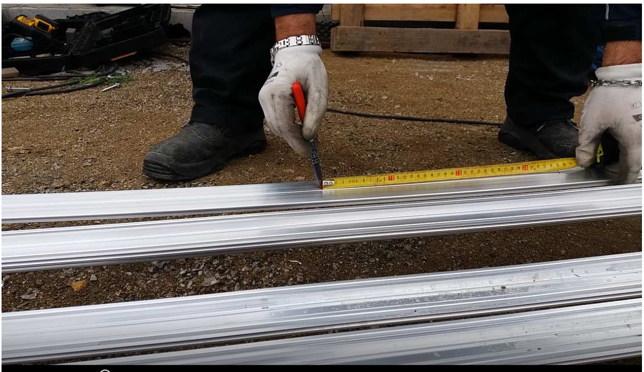
Foto 4. Příprava upevňovacího profilu – rozměření kotvení.
