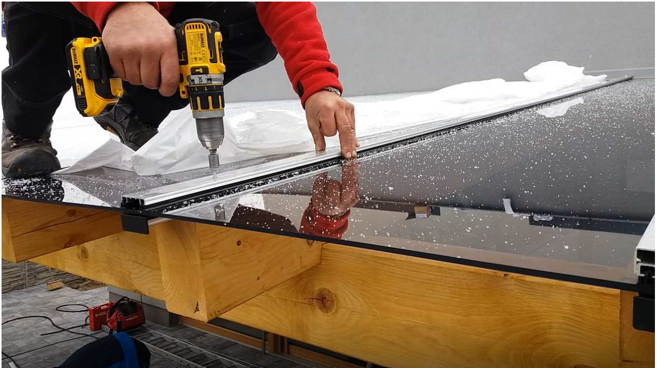
Foto 7. Připevnění upevňovacího profilu.
