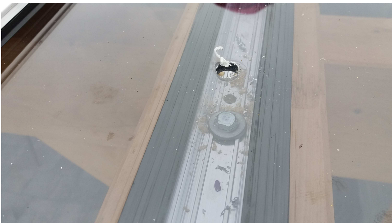
Foto 6. Předvrtání polykarbonátové desky a spodního profilu.
