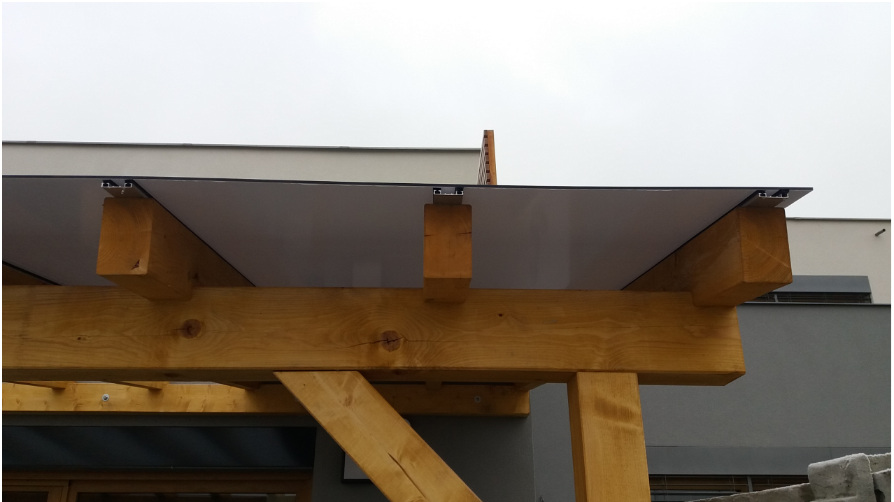
Foto 3. Rozměření desek polykarbonátu.
