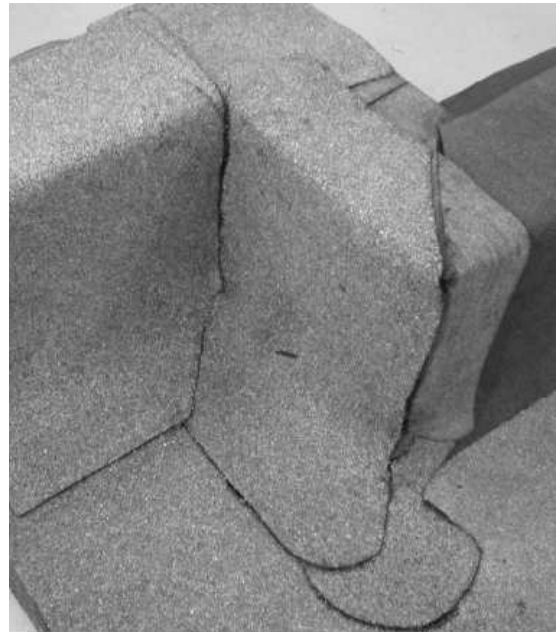
Obrázek /13/ Natavení koutové tvarovky 4b upravené zprava na tvar rohové tvarovky 2b a natavení koutové tvarovky 4a, obě s posypem
