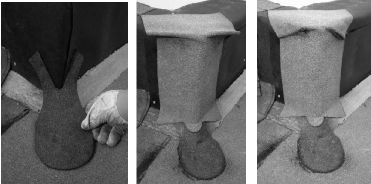
Obrázek /9/ Natavení univerzální tvarovky 1 a 2
