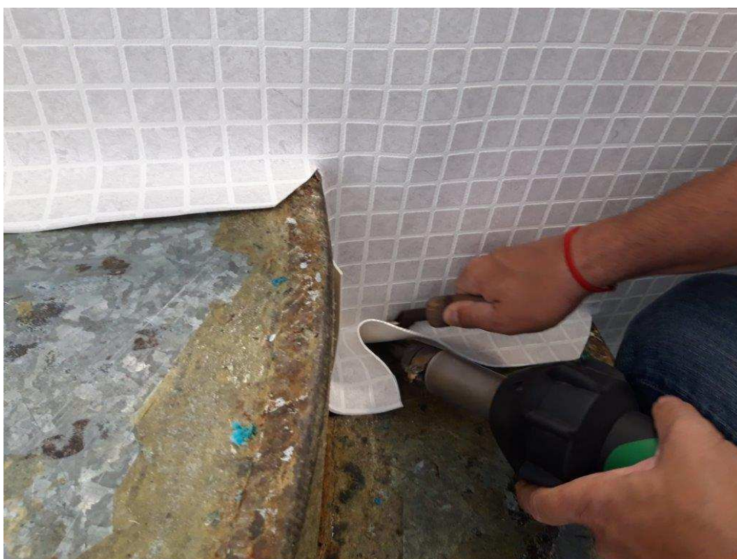
Foto 8. Přivaření fólie do hrany schodů
