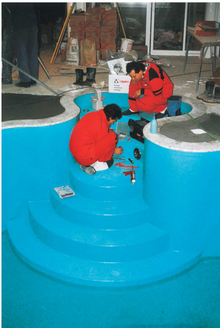
Foto 30. Realizace schodiště – bazénovou fólií lze řešit i tvarově velmi složité prvky
