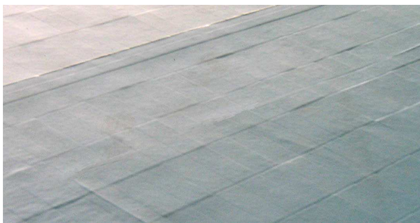
Foto 4. Prokreslení staré dlažby na povrch fólie.
