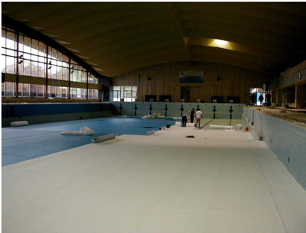
Foto 21. Bazén Ústí nad Labem – provádění dna bazénu
