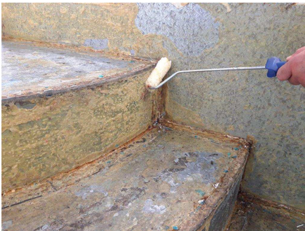
Foto 7. Nanášení lepidla na podklad
