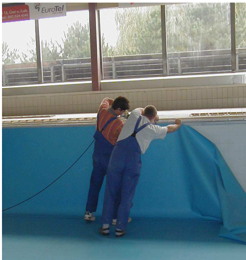
Foto 5. Provádění stěny bazénu.
