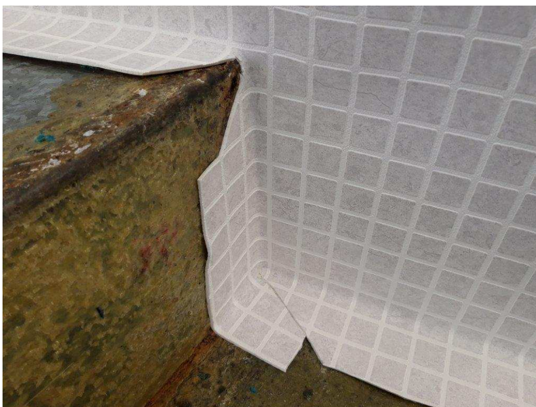
Foto 9. Svaření fólie v detailu
