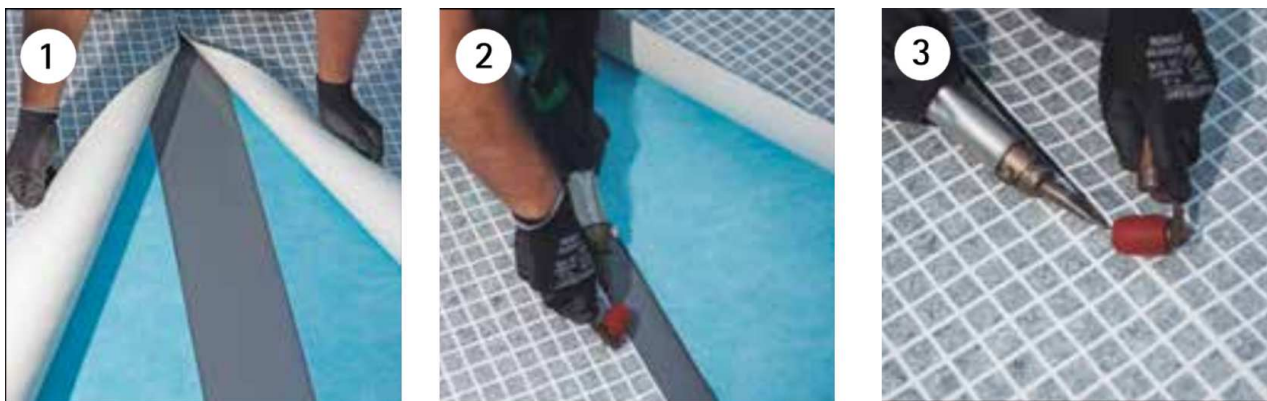
Foto 2. Navařování fólie CERAMICS na podvařovací pás
