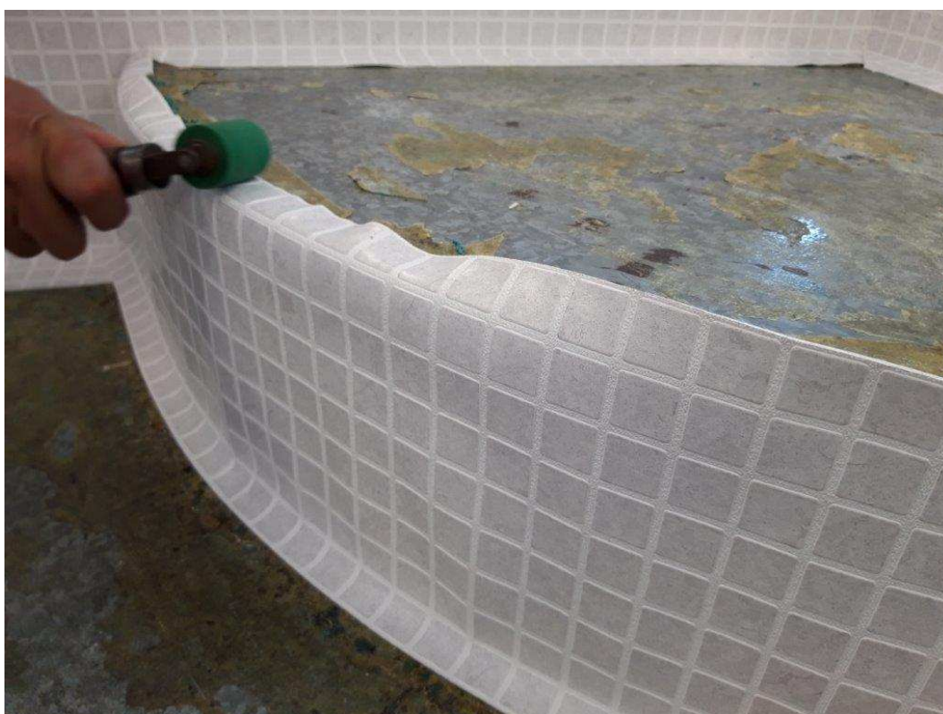
Foto 13. Nalepení fólie a nařezání fólie u obloukové podstupnice
