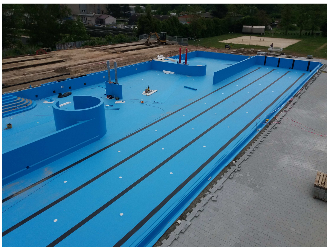
Foto 32. Realizace venkovního bazénu v Zábřehu na Moravě
