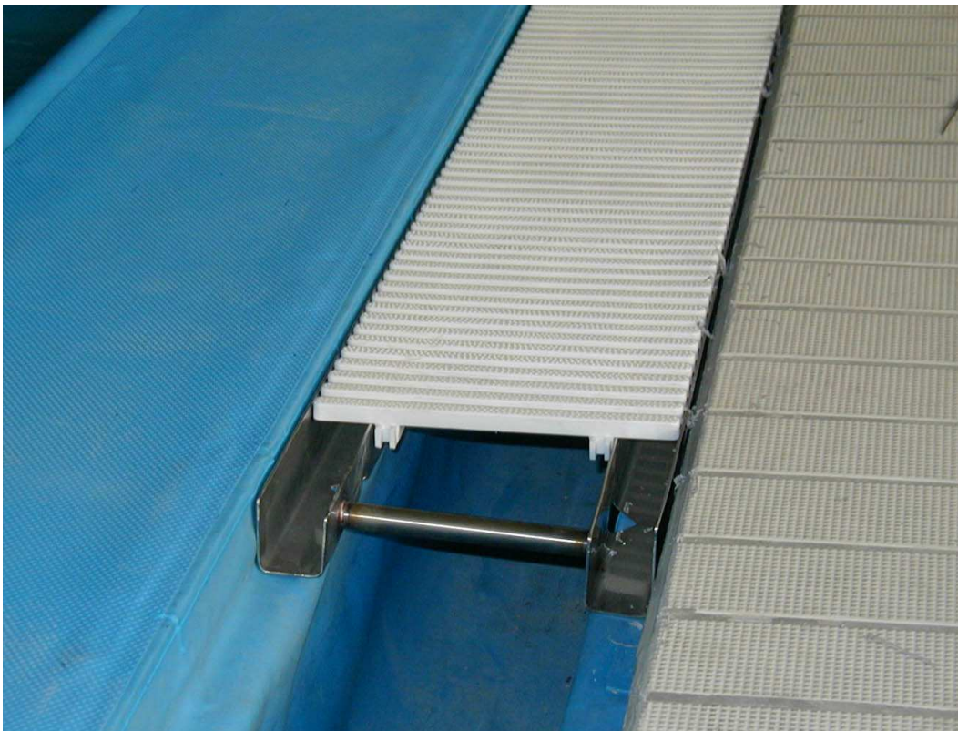
Foto 24. Bazén Ústí nad Labem – přelivný žlábek
