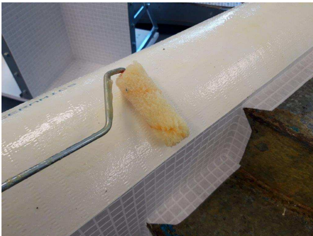
Foto 12. Nanášení lepidla na fólii
