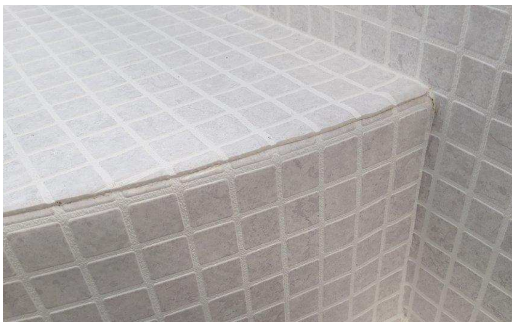
Foto 16. Pohled na svařený schodišťový stupeň
