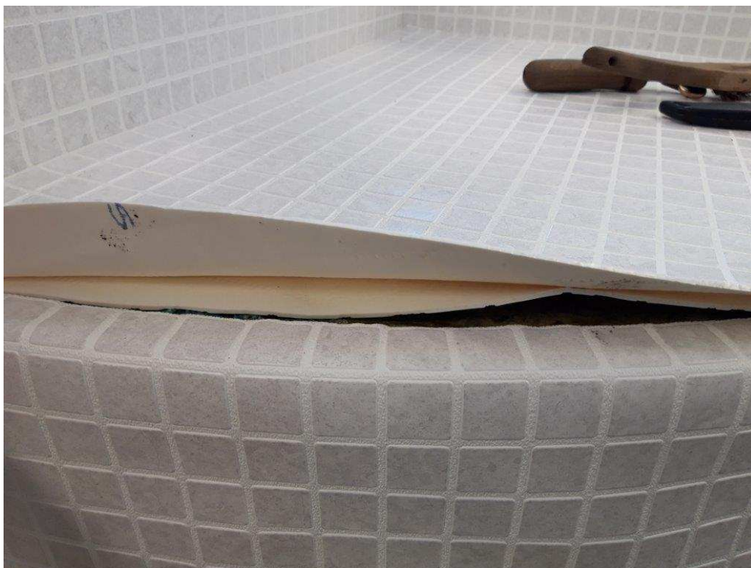
Foto 15. Pokládka fólie na stupeň s vypoďložením přířezem fólie
