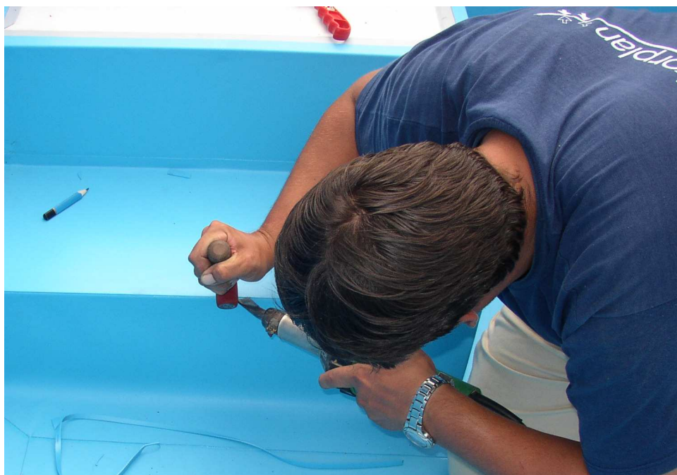
Foto 17. Zaoblčení stříhaného okraje fólie na hraně schodu.
