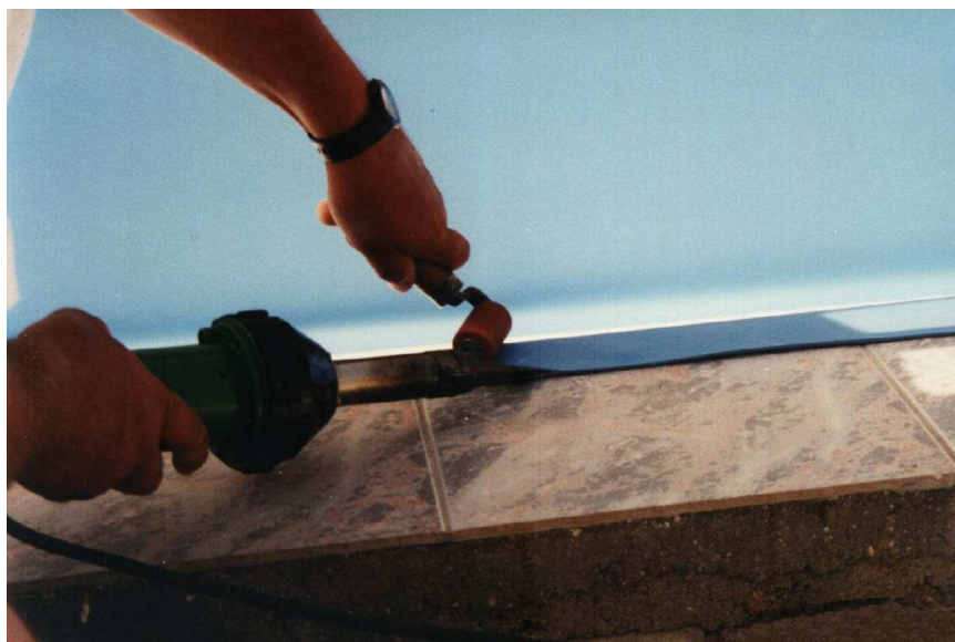
Foto 1. Navařování fólie na profil z poplastovaného plechu
