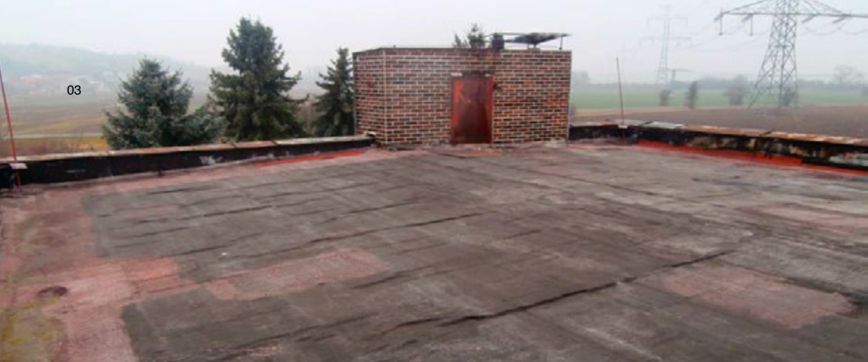
03 – 05| Pohled na původní střechu bazénové haly – utřžená hydroizolace od oplechování atiky, vrásky v souvrství oxidovaných asfaltových pásů a značné množství trhlin, to jsou jen některé z poruch
