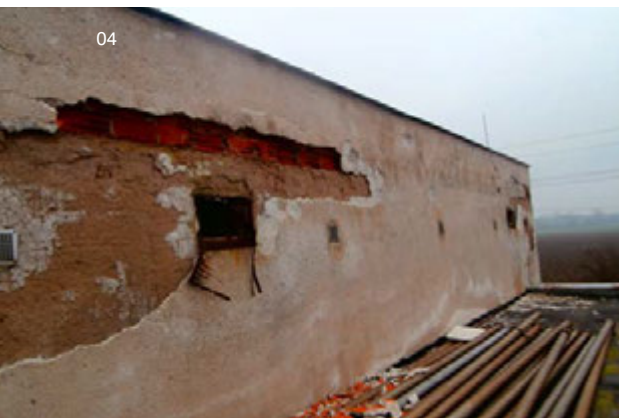
03 – 05| Pohled na původní střechu bazénové haly – utřžená hydroizolace od oplechování atiky, vrásky v souvrství oxidovaných asfaltových pásů a značné množství trhlin, to jsou jen některé z poruch
