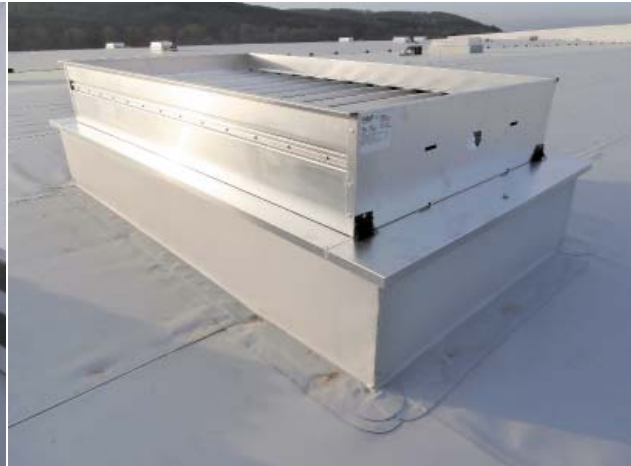
14| Ukončení hydroizolace na ventilátoru
