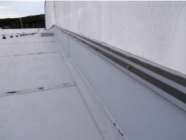
13| Ukončení hydroizolace na svislé stěně
