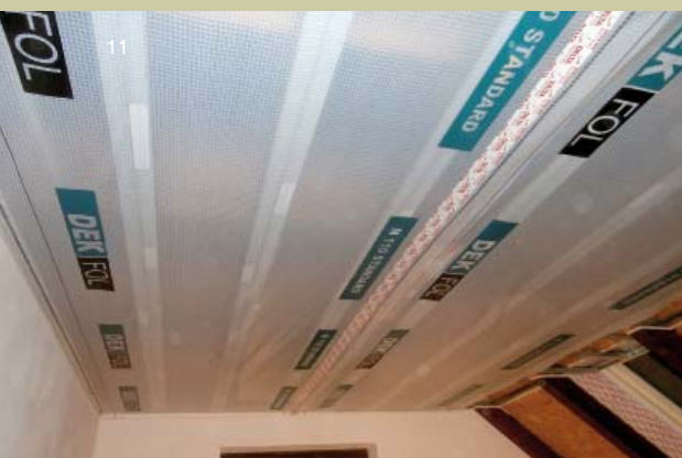
12| Pohled na PE fólii před kotvením sádrokartonových desek (měření B)
