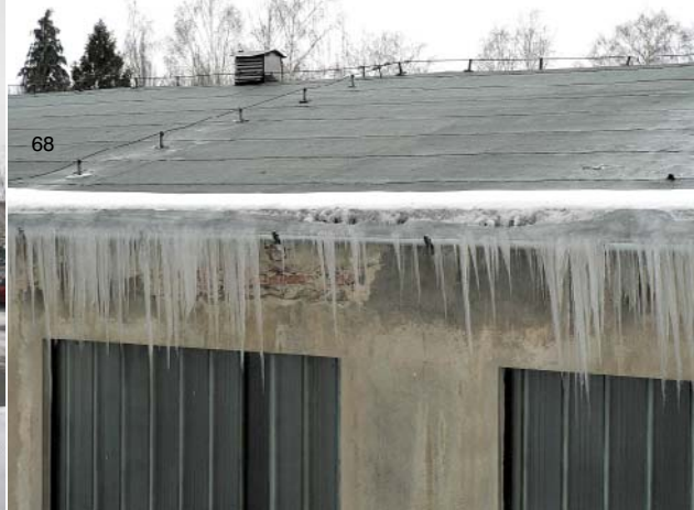
68| Jižní Čechy – namáhání navazující konstrukce vodou přetékající i vnitřní hranu zaledněného žlabu
