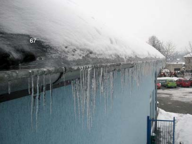
67| Jižní Čechy – namáhání navazující konstrukce (dřevěné obložení římsy) vodou přetékající i vnitřní hranu zaledněného žlabu
