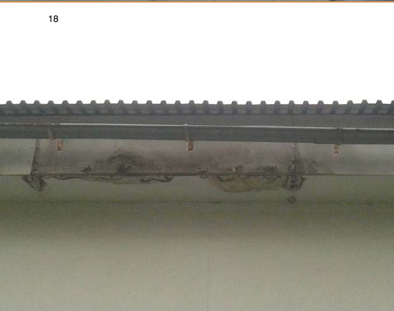
19| Bezpečná poloha žlabu vůči chráněným konstrukcím – velký přesah střechy přes obvod domu
