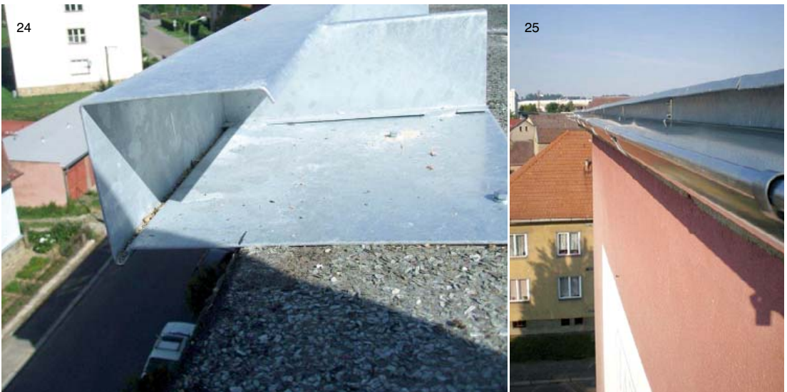
24, 25 | Záběry z realizace detailu z /obr. 23/
