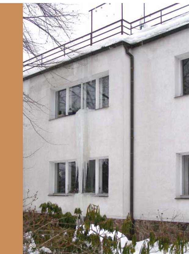
69| Podkrkonoší, Nová Paka – namáhání navazujících a chráněných konstrukcí (fasáda, parapety, výplně otvorů) vodou přetékající i vnitřní hranu zaledněného žlabu
