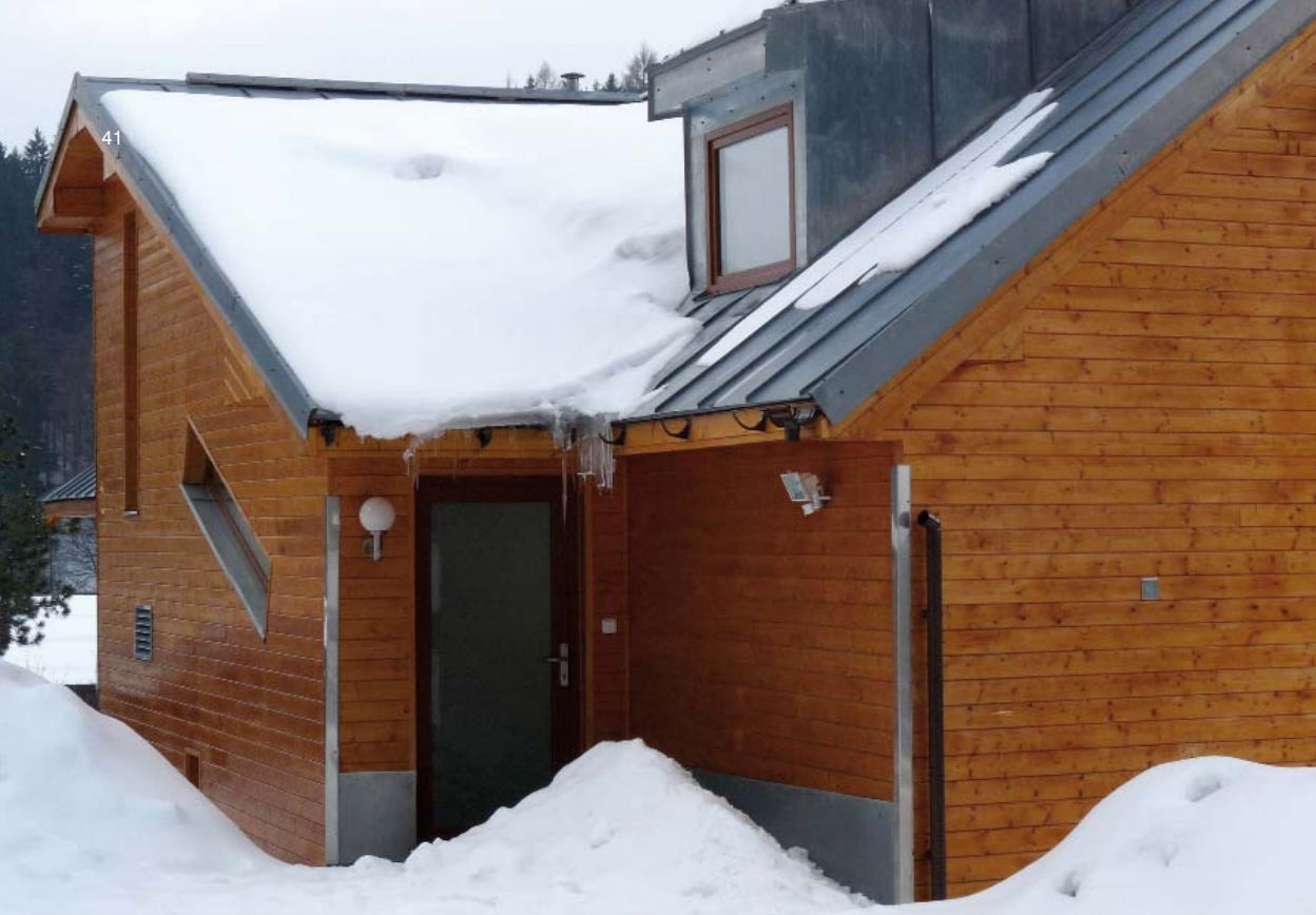
41 | Krkonoše – dočasné vyjmutí žlabu z uzpůsobených háků je možnou variantou jejich ochrany před působením sněhu a ledu
