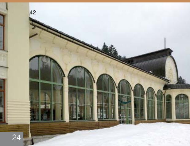
42 | Krkonoše – dočasné odehnutí uzpůsobených háků včetně osazeného žlabu je možnou variantou jejich ochrany před působením sněhu a ledu. Přesah střechy v kombinaci s demontovatelnou dřevěnou předstěnou zajišťuje ochranu navazujících a chráněných konstrukcí (zabraňuje kontaktu paty obvodové stěny a sněhu akumulovaného kolem objektu). Okolo objektu je dostatek prostoru pro akumulaci sněhu
