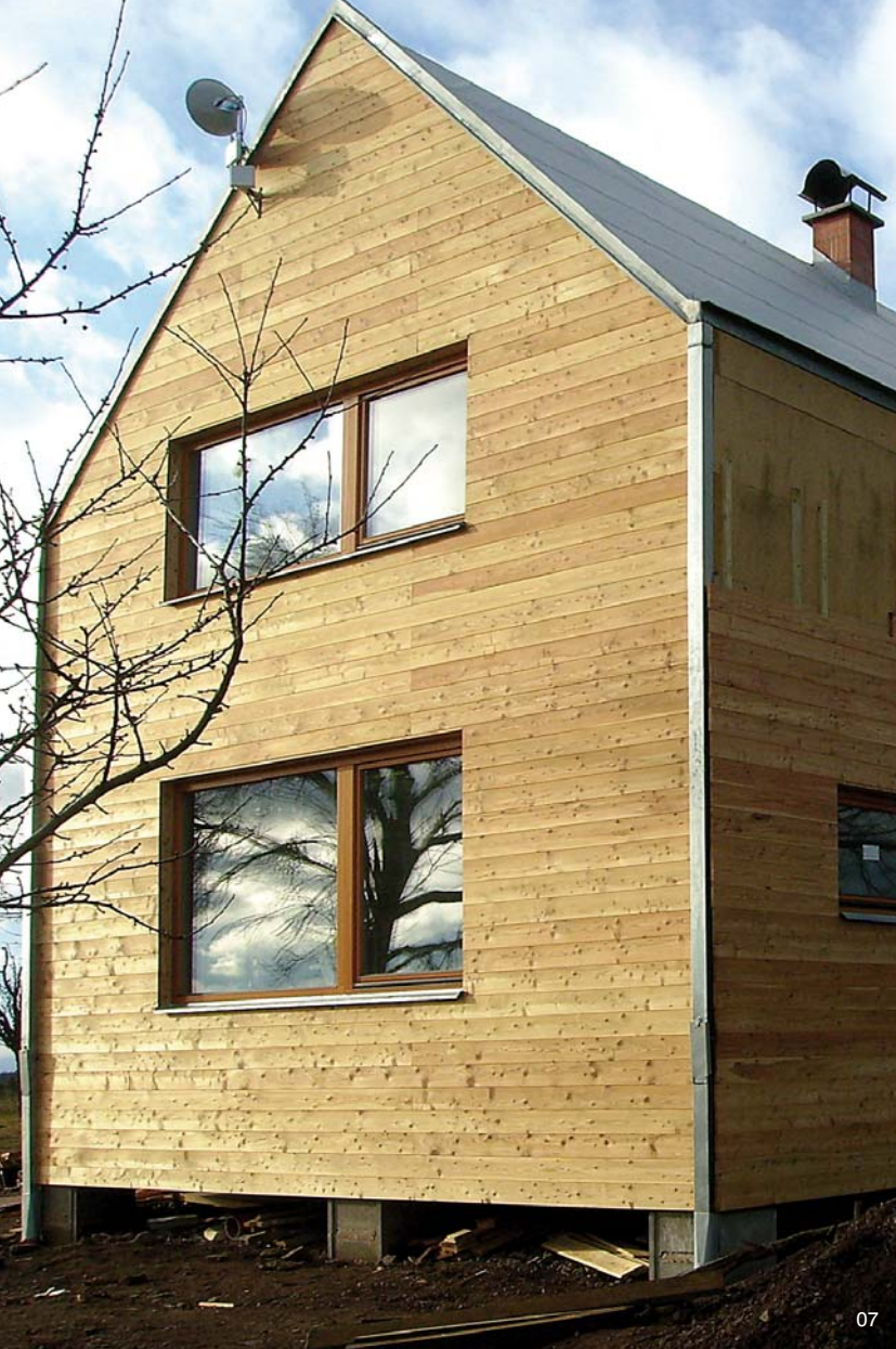
07 | Pohled na RD založený na betonových pilířcích
