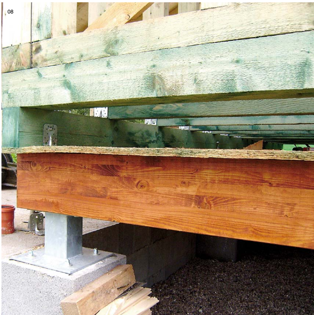
08 | Detail podlahy založené na betonových pilířcích
