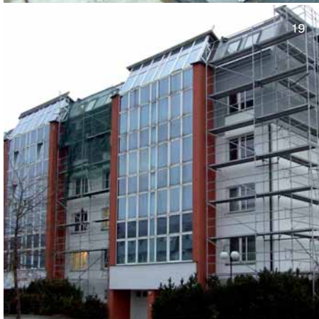
17| Nově osazená střešní okna do vrstvy tepelné izolace (vzadu), původní okna před demontáží (vpředu)
