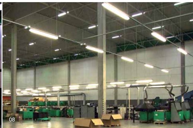
Obr. 11 | Body měření a vypočítané hodnoty: v sekci A je 40 bodů v rozteči 3,5 x 1,7 m, v sekci B jsou na každém z 20 pracovišť 4 body v rozteči 1,0 x 1,0 m a v sekci C je na každém z 5 pracovišť 10 bodů v rozteči 1,0 x 1,0 m
