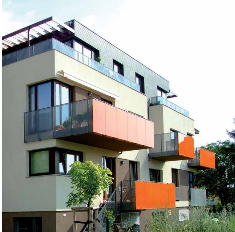
01 | Balkóny stíní okna ve spodním podlaží
